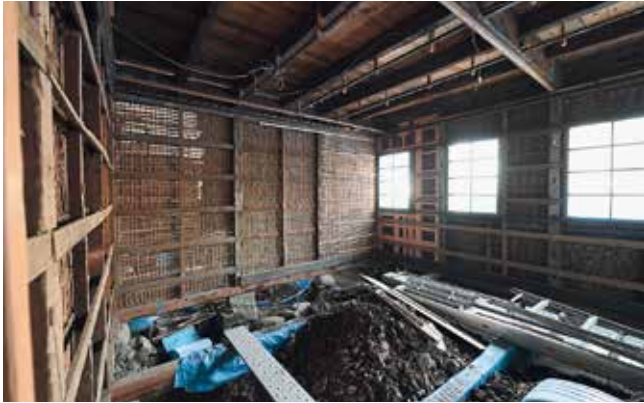
旧開智学校校舎 現在の内部の様子
