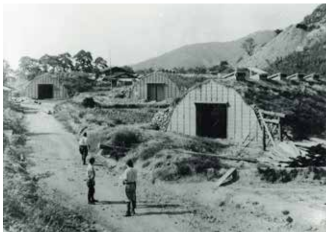
里山辺林東部地区に完成していた半地下工場 「松本市における戦時下軍事工場の外国人労働実態調査報告書」より
