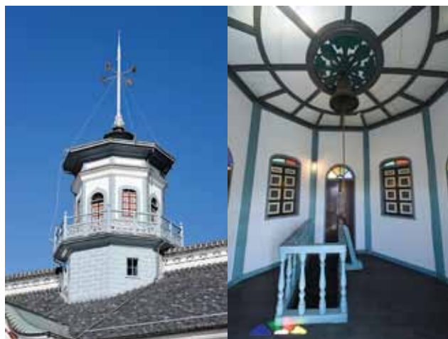
左：八角塔屋外観 右：八角塔屋内観 撮影：山田毅
