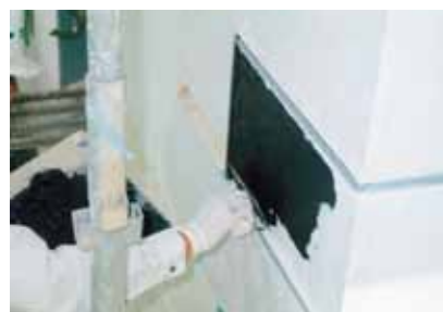
左官工事の様子（平成16～17年保存修理工事）
