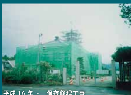
平成16年～ 保存修理工事
