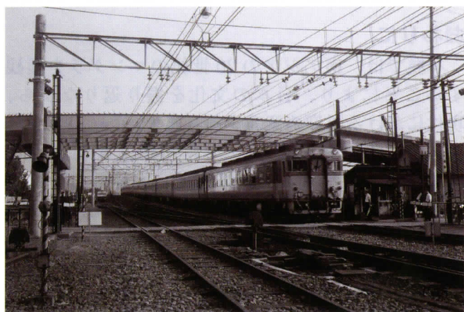
② 建設中の中条陸橋とディーゼル特急しなの
