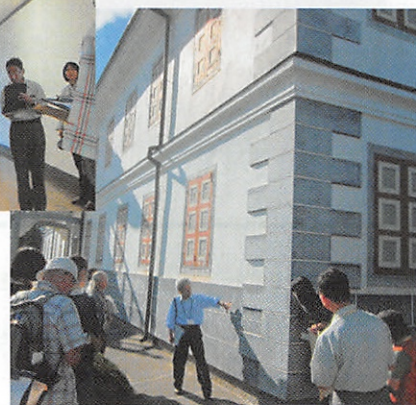
外壁は漆喰塗、腰壁は黒漆喰の目地
