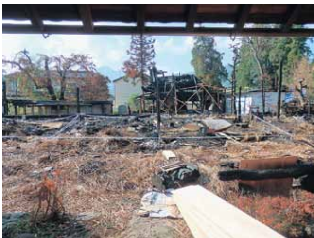
北門から主屋、斎館の焼失跡を望む
