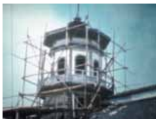
旧開智学校校舎移築工事の様子
