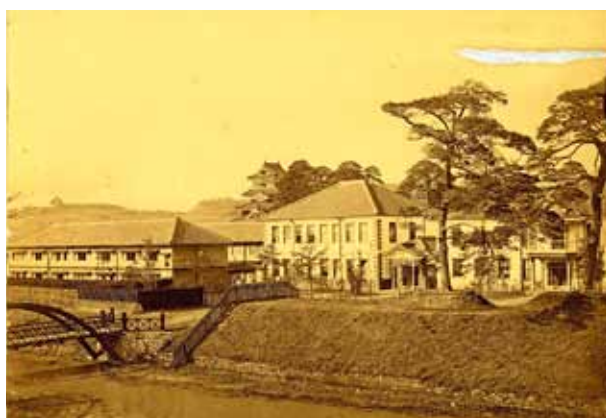
松本城を背景に、漆喰系擬洋風校舎と下見板張校舎が並ぶ松本中学校
